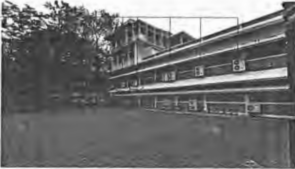
ถ่ายภาพมุมมองถนนพหลโยธิน เพื่อหาขนาดเหล็กที่จะติดกับพาด
